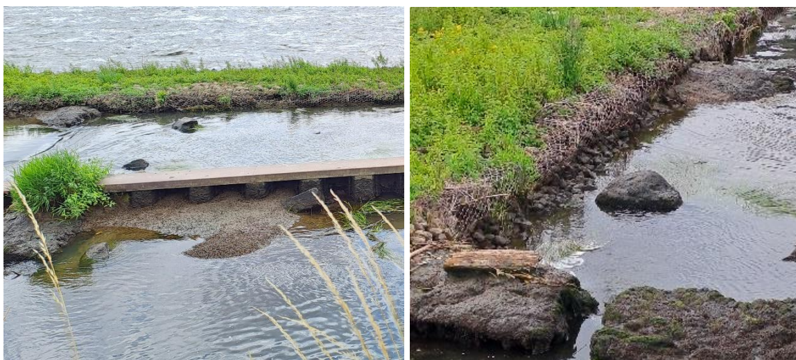
Figuur 4-23 Zicht op uitspoeling schanskorven landtong (Belfeld)
