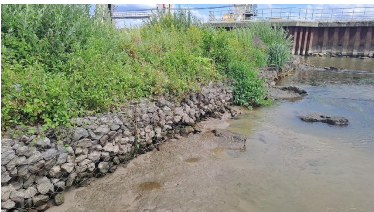
Figuur 4-13 Schade aan schanskorven langs landtong
